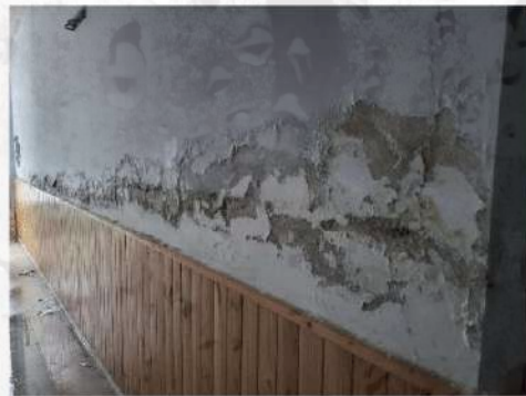
Ejemplo de humedad por capilaridad
