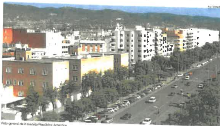
Vista general de la avenida República Argentina
